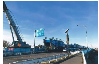
(50号線4車線化工事)
