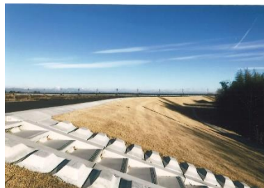
(川島地区堤防)
