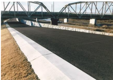
(川島地区堤防)
